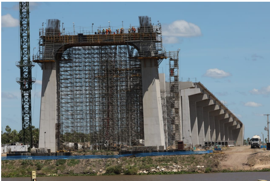
Imagem 1 – Obra do lado brasileiro da Ponte binacional entre Porto Murtinho e Carmelo Peralta
